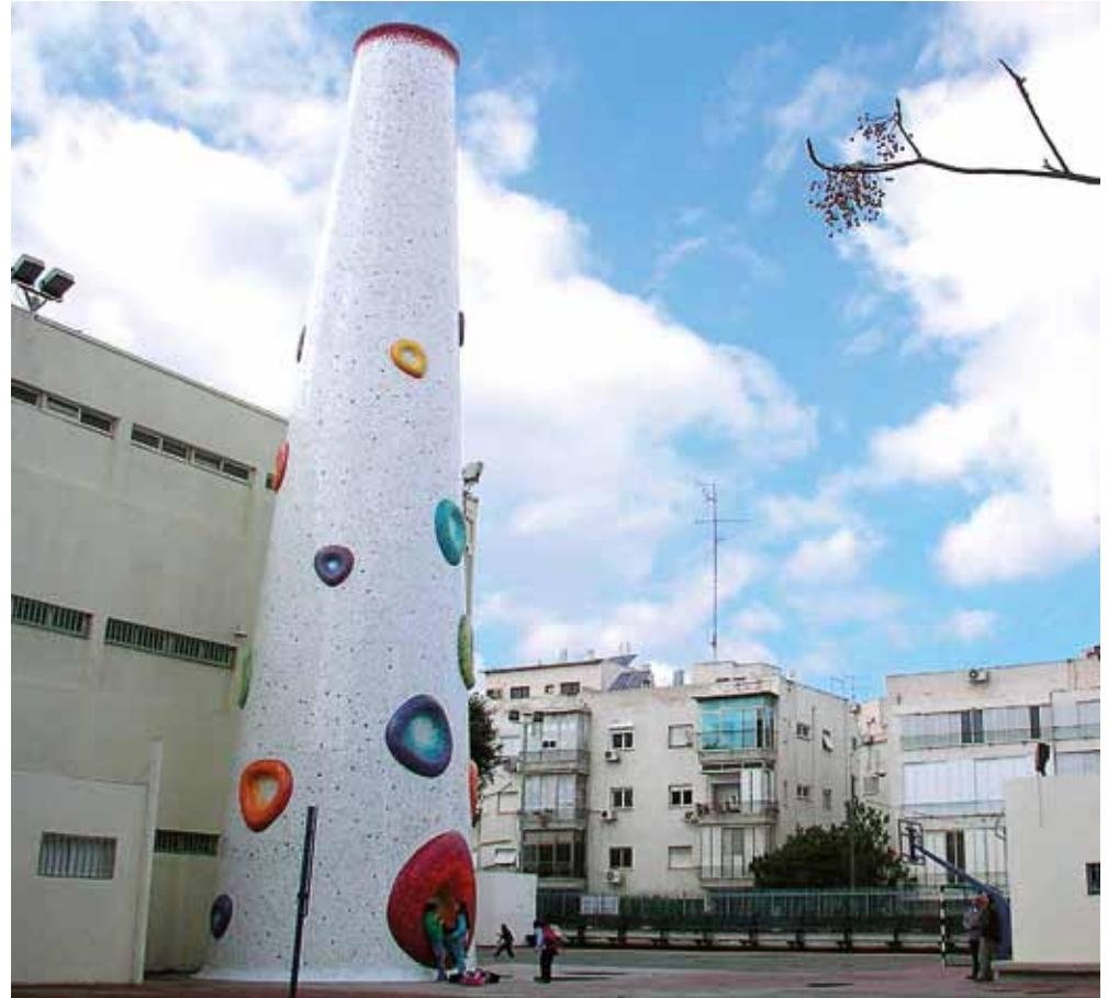
Una vez instalada la base estructural de la chimenea, formada por un cilindro de acero, se revistió el cuerpo con materiales cerámicos fragmentados en piezas irregulares
